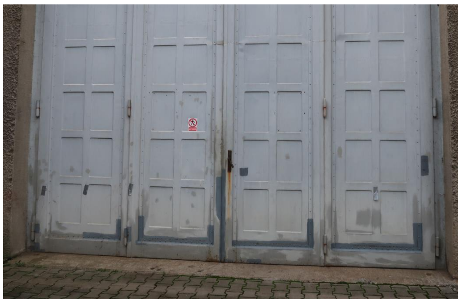
Naprawa bramy do hali maszyn wraz z mocowaniem systemu ochrony przeciwpowodziowej
