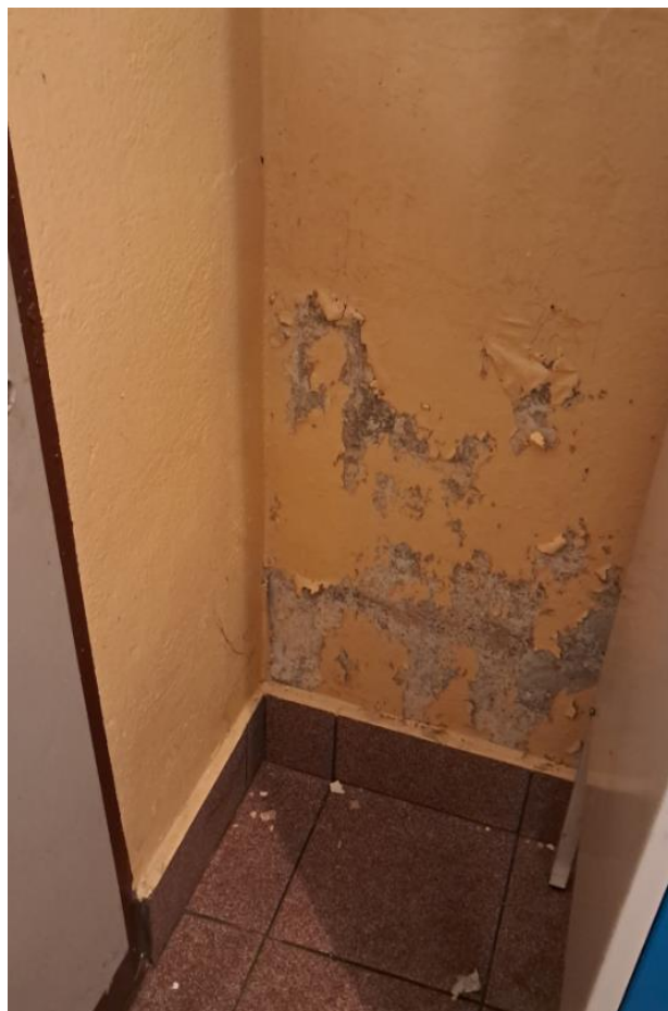
Naprawa tynków i powłok malarskich w pomieszczeniu szatni poziom -1
