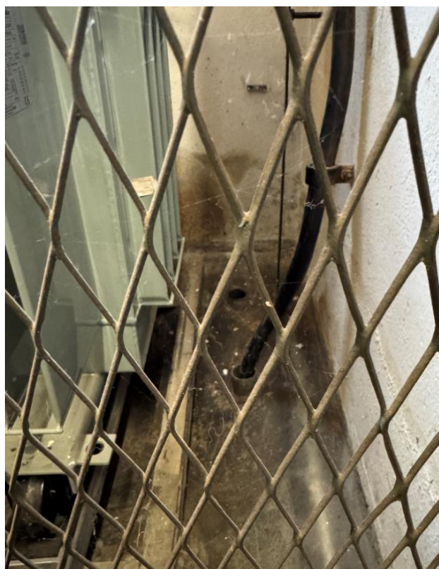
Naprawa uszczelnienia przepustów kablowych przy transformatorze potrzeb własnych
