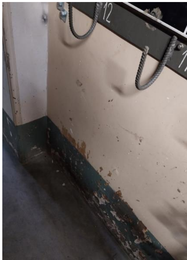
Tynki do naprawy po obu stronach przy wejściu do rozdzielni
