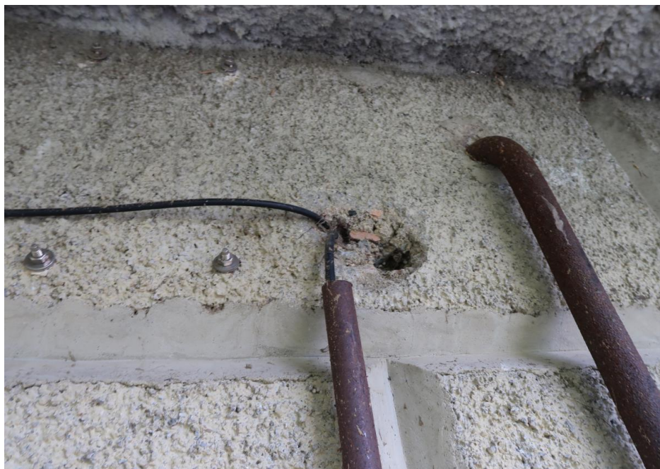
Naprawa uszczelnienia przepustów kablowych wraz z montażem luźnych przewodów
