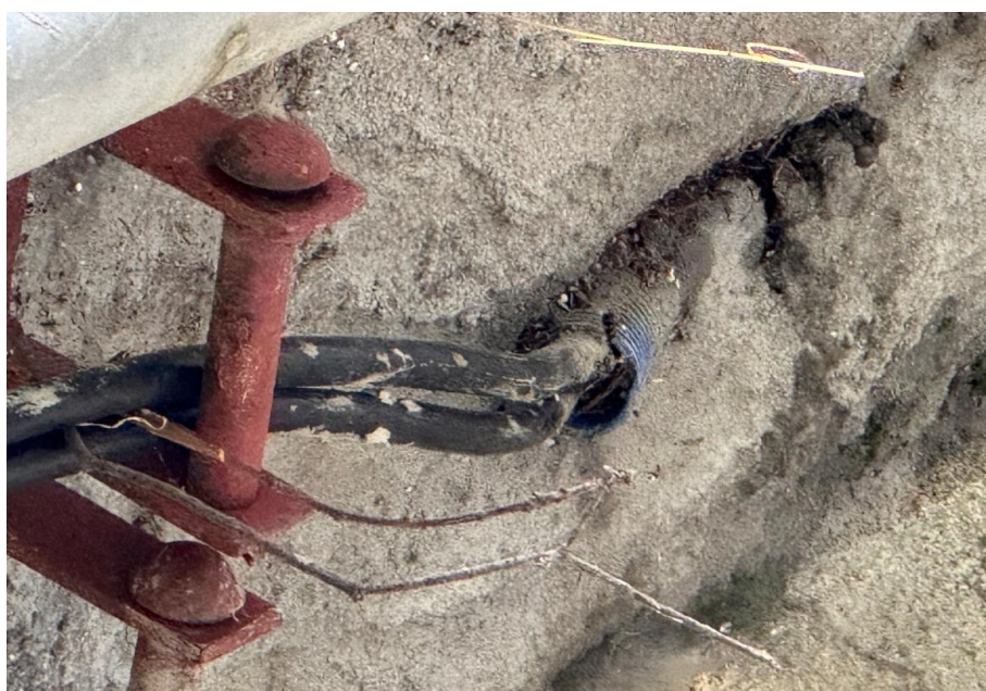
Naprawa uszczelnienia przepustów kablowych wraz z naprawą mocowania kabli
