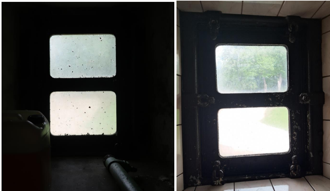
Oczyszczenie stolarki okiennej wraz z jej malowaniem
